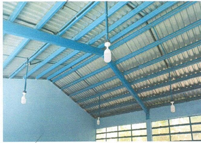
Foto 2: Reparación de sistema eléctrico
