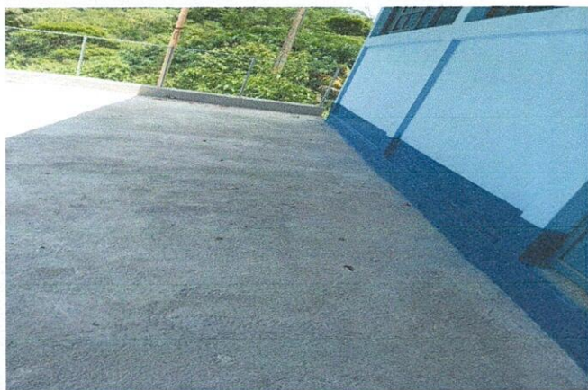
Foto 3: Losa de patio
