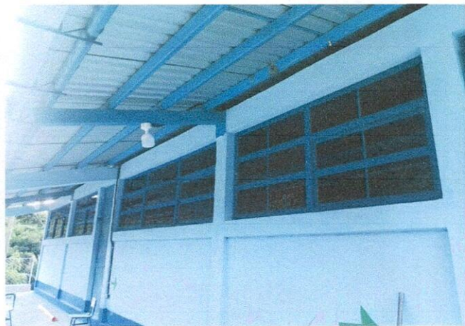
Foto1: Mejoramiento de ventanas
